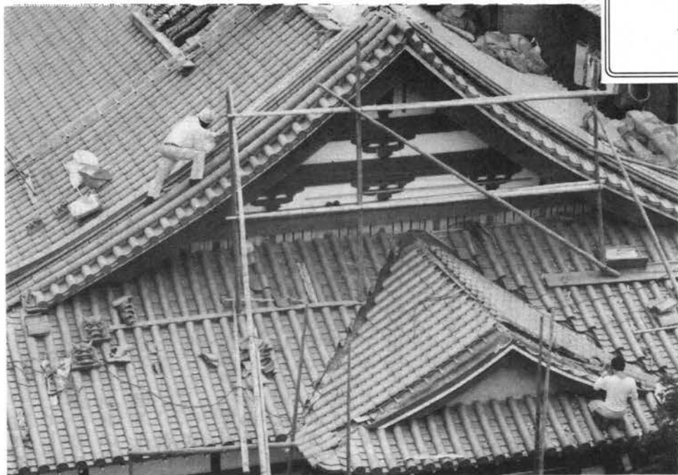
屋根の修復もいよいよ最後の鬼瓦の設置まで進んだ
