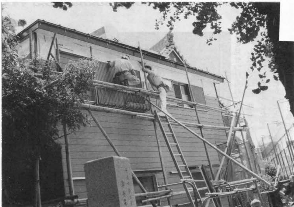
庫裡の工事も最終段階に(5日完了)
