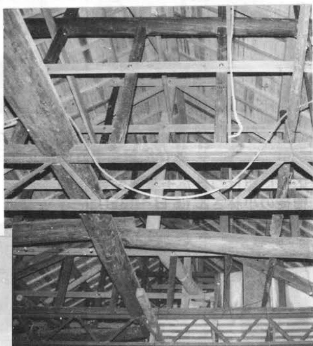
本堂内の天井の工事が始まった(14日) 写真は、天井を取り外した本堂の屋根裏 本堂内の天井は、寺院建築にふさわしい 「格天井 ごうてんじょう 」になった
