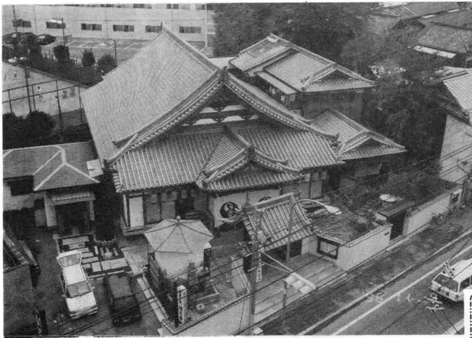
修復がすべて完成した源立寺
