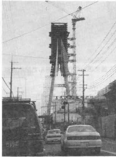
池田の橋脚の工事延長の延高速の阪神 風は変わるか（工事中の橋脚）
