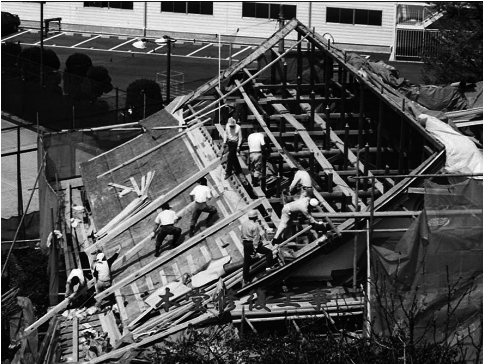
阪神淡路大震災時の源立寺本堂修復工事（平成7.4）
