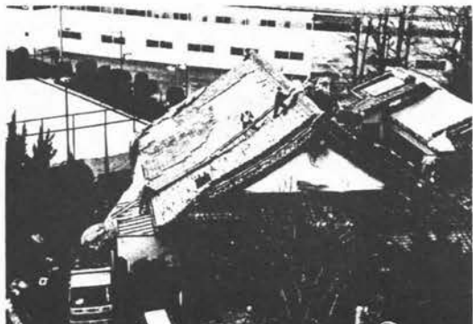
屋根瓦降ろし 1.23
