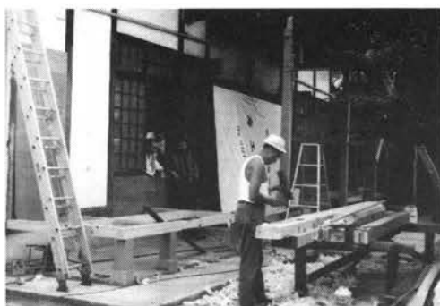
工事中の本堂玄関
