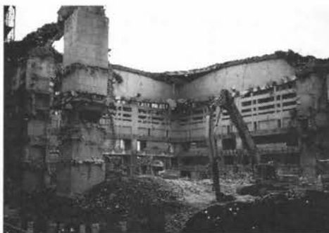
9月中旬、大客殿の解体が始まった
