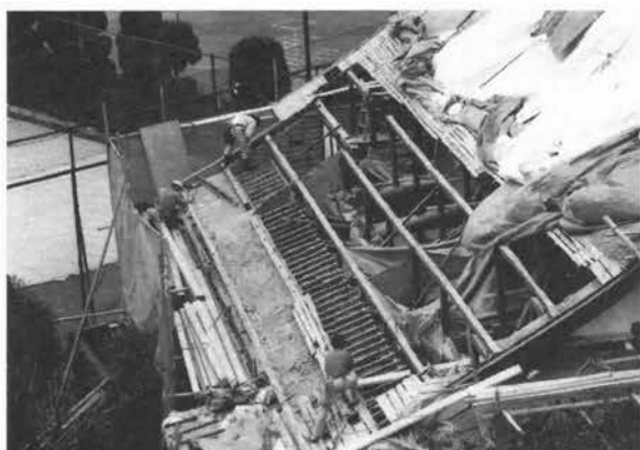
野地の解体作業 4.18
