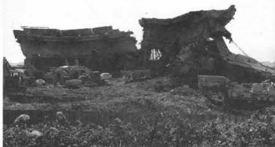
無残な姿をさらす正本堂解体現場
