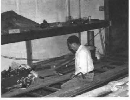
内陣・須弥壇の改修工事
