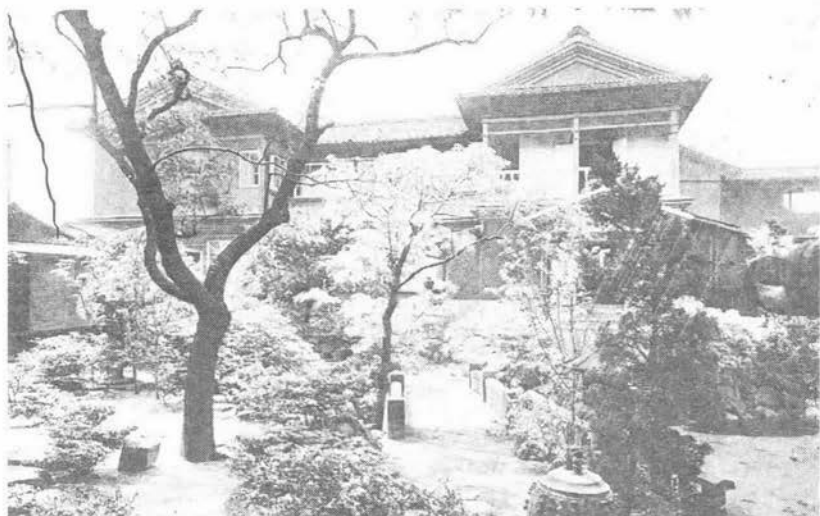
庭園内から見た洋館
