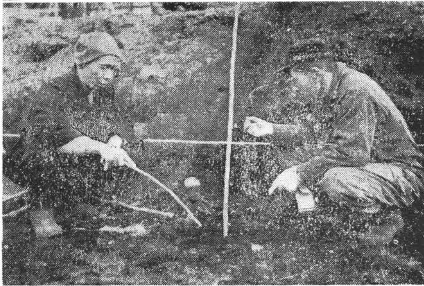
古銭が発見された大講堂基礎工事現場(『大日蓮』より)
